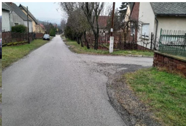
Petőfi utca csatlakozása (20. ábra)
