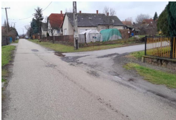
Jókai Mór utca csatlakozása (9. ábra)
