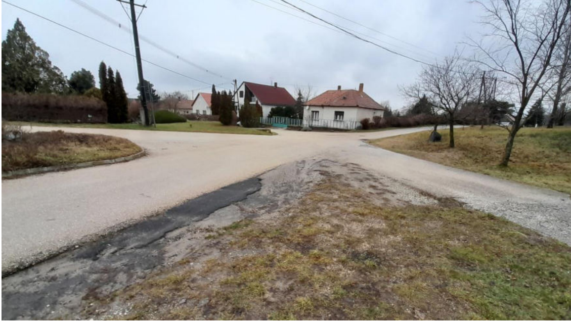
Kisfaludy utcai (036-os hrsz) kereszteződés (31. ábra)
