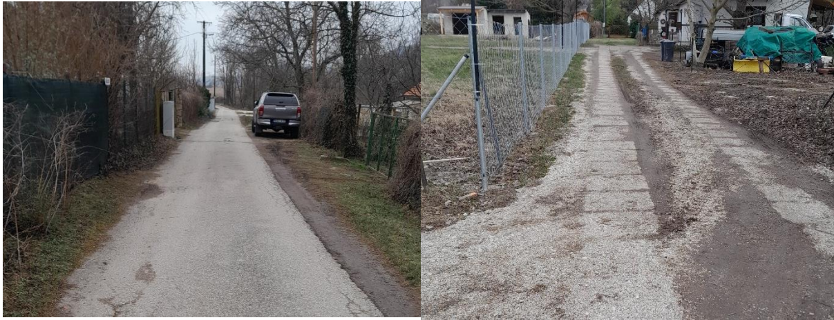
Nádas utca aszfalt burkolatú utca, egy része földesút. (143. ábra)
