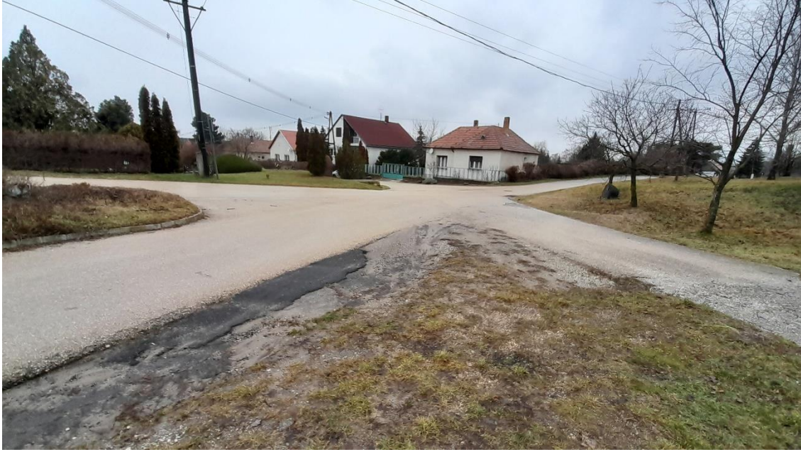
Kisfaludy utcai (036-os hrsz) kereszteződés (31. ábra)
