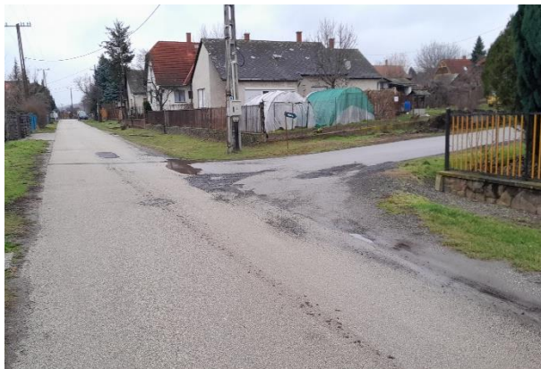
Jókai Mór utca csatlakozása (9. ábra)
